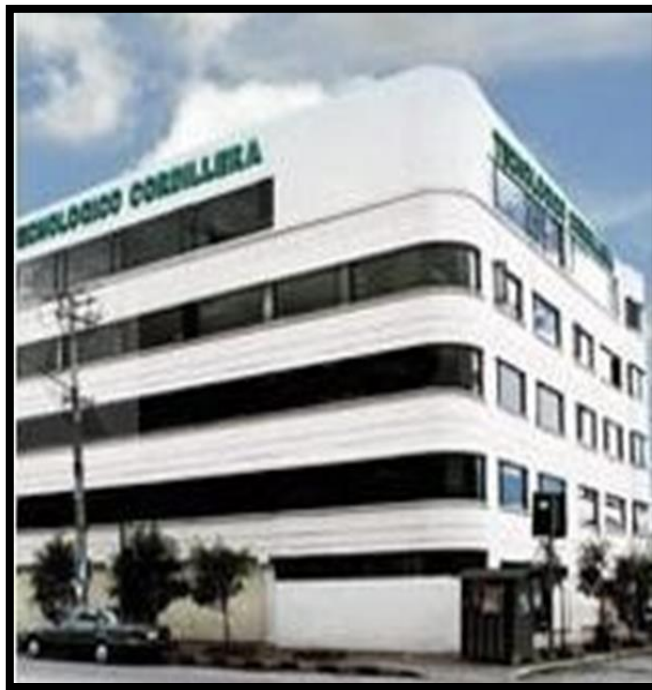
Edificio Logroño Fuente: cordillera.edu.ec
