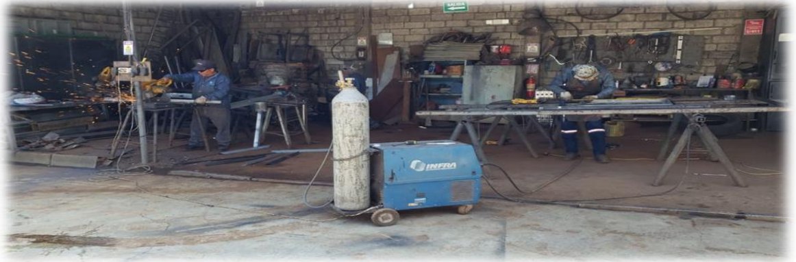
Figura 48: Zona de Producción Fuente: Estructuras metálicas Coello
