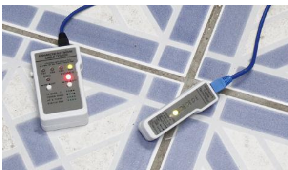
Nombre: prueba de conectividad de cable con testeador
