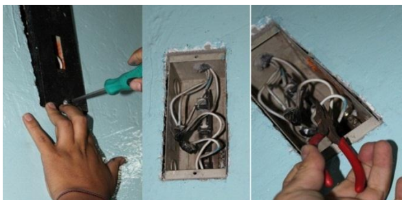
Nombre: Verificación conexión a tierra
