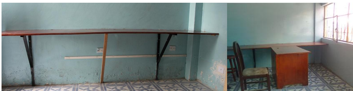
Nombre: Instalación demuebles para ubicar equipos
