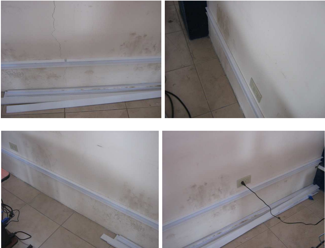
Instalación de Canaletas
