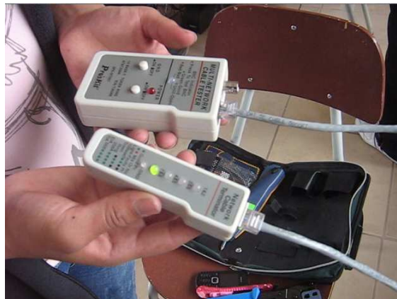
Testeo de Cables
