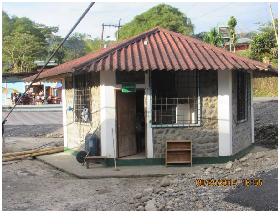
Casa de vigilancia dentro del Dique de Shell
